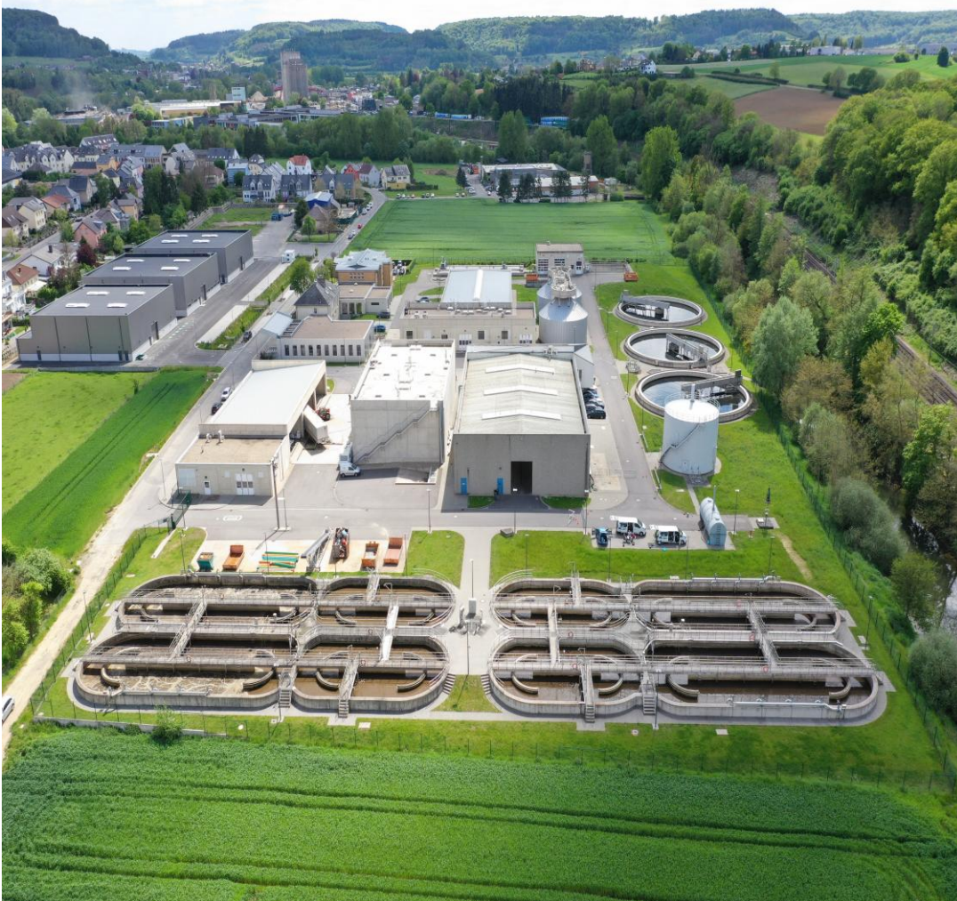
Kläranlage in Beringen/Mersch (Foto: AGE)
