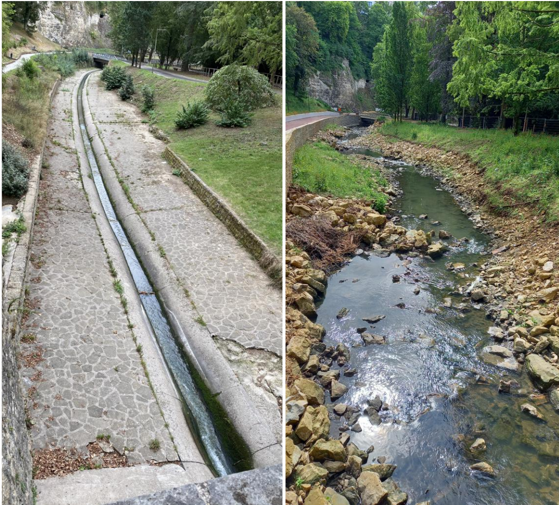
Renaturierung der Pétrusse in Luxemburg-Stadt (Foto: AGE)
