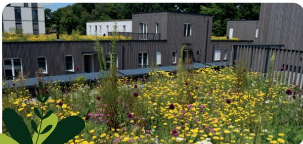
Grâce à la végétalisation, l'étanchéité de la toiture est beaucoup moins exposée aux variations de température : -5°C en hiver jusqu'à +70 °C en été sans végétalisation vs. 10 °C en hiver et jusqu'à +30 °C en été avec végétalisation. De ce fait, la durée de vie de la toiture est augmentée en moyenne de 10 à 20 ans.
