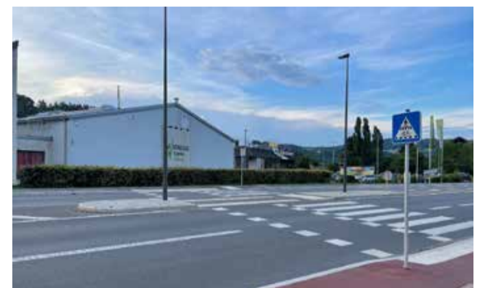
Positives Beispiel: Übergang auf der Höhe von McDonald's in Ingeldorf
