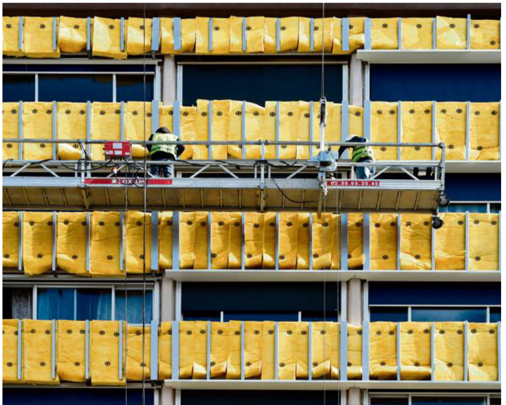
Travaux d'isolation thermique de logements sociaux, à Paris. FREDERIC ACHDOU/REA
