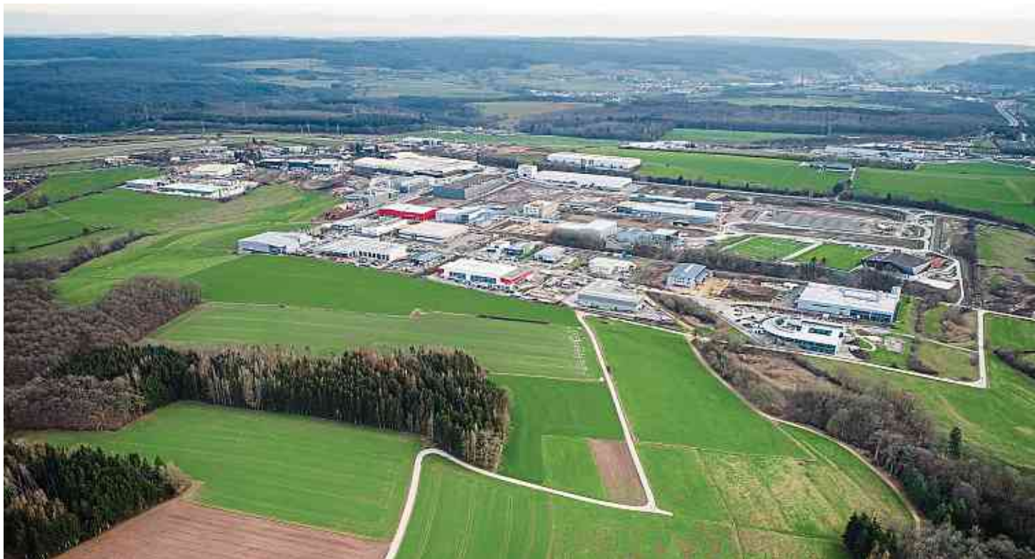
Wann der Internet-Riese Google mit dem Bau des Data-Centers in Bissen beginnen wird, ist noch nicht klar.
