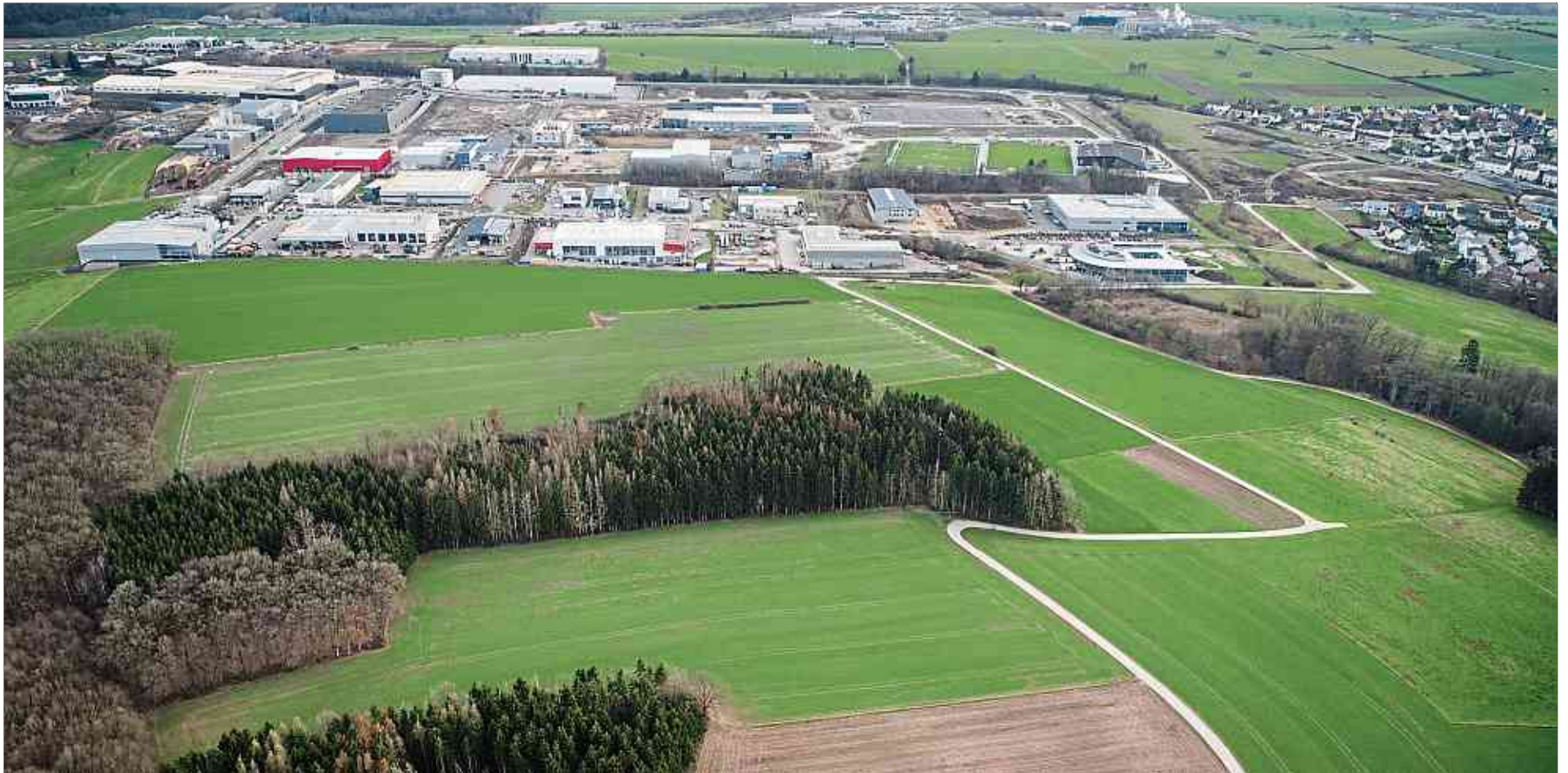
Daten brauchen Platz, sehr viel Platz. Das Gelände bei Bissen befindet sich derzeit in der öffentlichen Prozedur zur Umklassierung in eine Zone spéciale.
