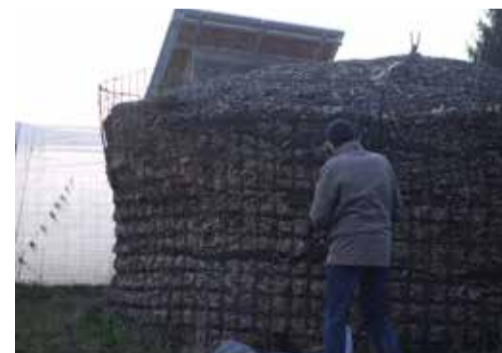
Durch den Verrottungsprozess erhitzt der Biomeiler (aus Grünschnittkompost) mit Wasser gefüllte Schläuche, die dann den Folientunnel erwärmen.
