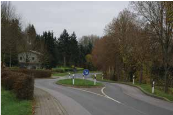
Eine Straßenverschwenkung mit Mittelinsel - ein Engpaß - führt zu einer Geschwindigkeitsreduktion (oberes Foto Mittelstreifen bei Münden - unteres Foto Ortseingang Bollendorf). Ebenso wie gezielte Fahrbahnverengungen (unteres Foto).
