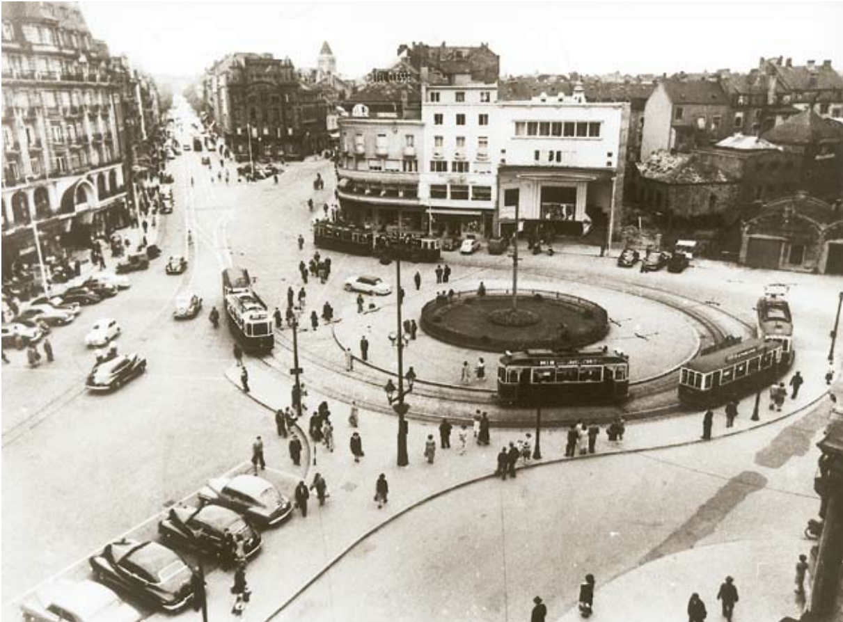
Das aktuelle Denkmalschutzgesetz greift nicht. Beispiel Kino Marivaux: noch unter Robert Krieps auf's "Inventaire supplémentaire" gesetzt, wurde es trotz positivem Gutachten der COSIMO von Erna Hennicot-Schoepges davon wieder gestrichen – und vor kurzem abgerissen.
