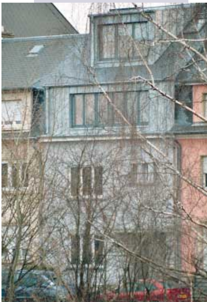
...nach der Sanierung: 4 Liter-Haus *
