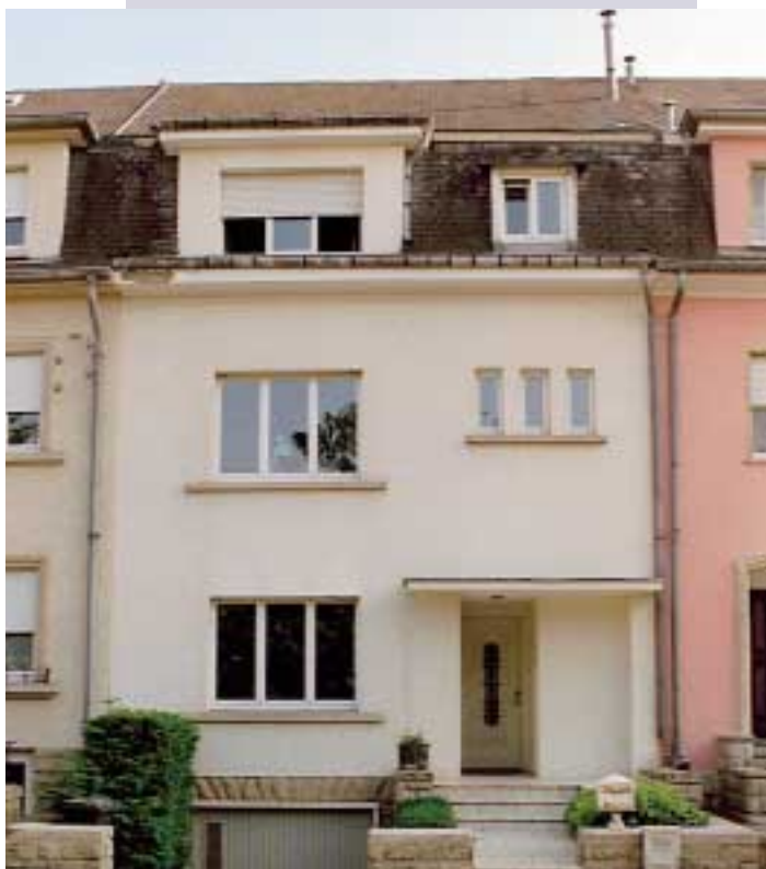
Vor der Sanierung: 22 Liter-Haus *
