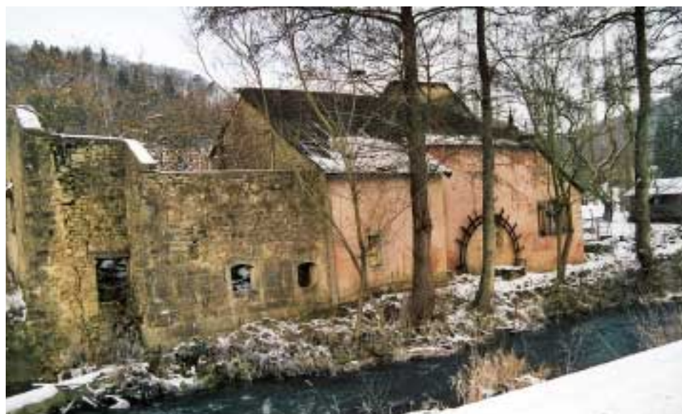
Die Follmühle in Simmern: die Erhaltung dieser Mühle dürfte gleichzeitig Wasserwirtschaftsamt und Denkmalpflegeamt interessieren...
