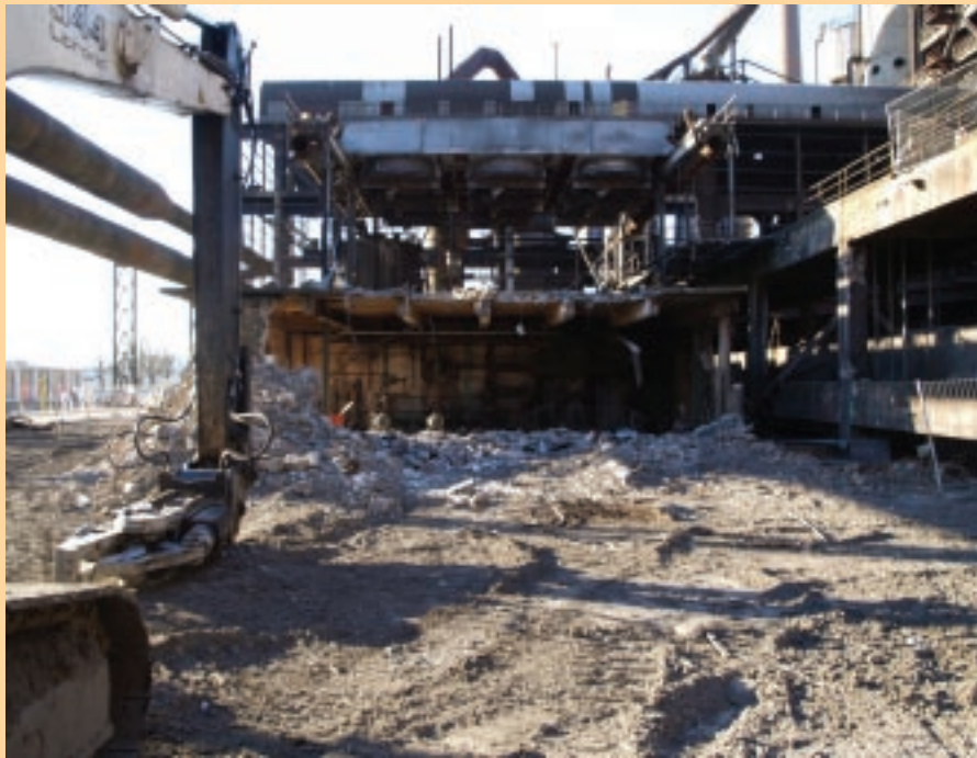
Abriss des High-Ways auf einer Länge von 20 Metern
