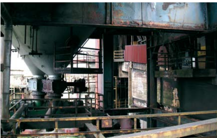
Würde Luxemburg über einen Aktionsplan "Denkmalschutz" verfügen, so wären wir heute nicht in der Situation, dass die einmalige Hochofenanlage in Esch-Belval Gefahr laufen würde, zerstört zu werden. Es gilt dieses wertvolle industriegeschichtliche Kulturgut in seiner Funktionalität zu erhalten.
