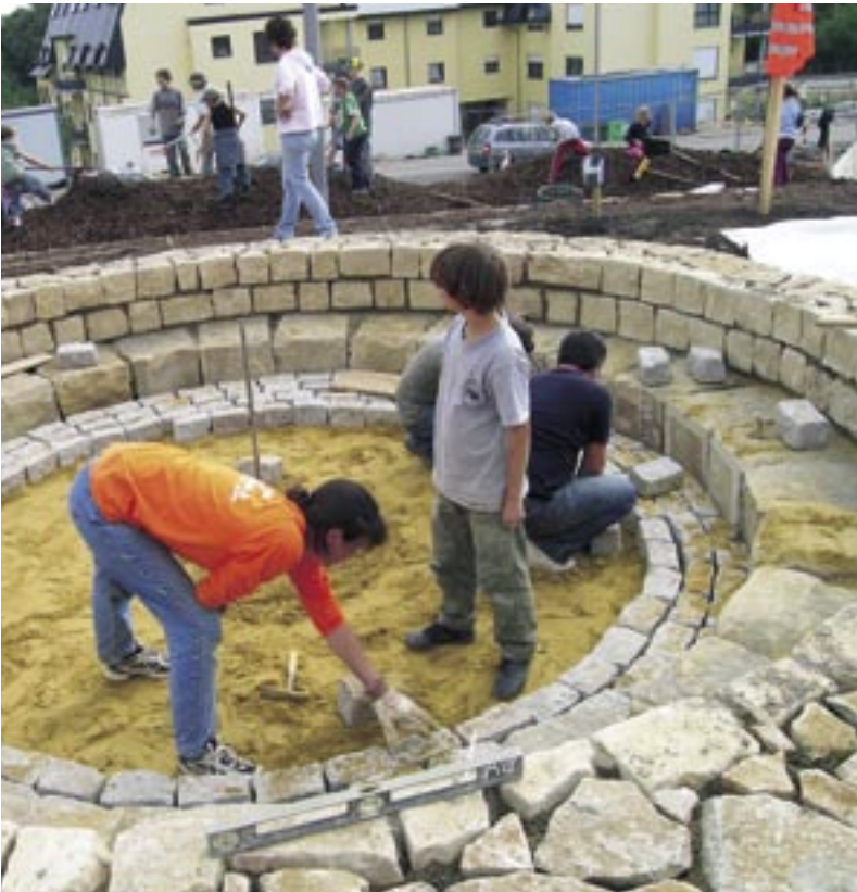
Ein Atrium wird gebaut
