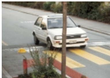
Zebrastreifen auf Bürgersteigniveau kombiniert mit einseitiger Fahrbahnverengung: durch die Rampe wird das Tempo auf der Fahrbahn verringert und durch die Verengung wird die Überquerungsdistanz kürzer.
