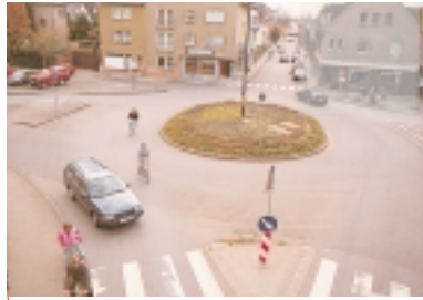
Der Kreisverkehr vorher und nachher: die Fahrbahn wurde im Zuge des Umbaus deutlich eingeeignet und umlaufend wurden Radspuren markiert. Im Vordergrund führt die Veloroute tangential über den Kreisverkehr, so dass Radfahrer direkt geradeaus weiterfahren können. Durch Aufpflasterungen wurde die Furt der Veloroute sicher gestaltet.
