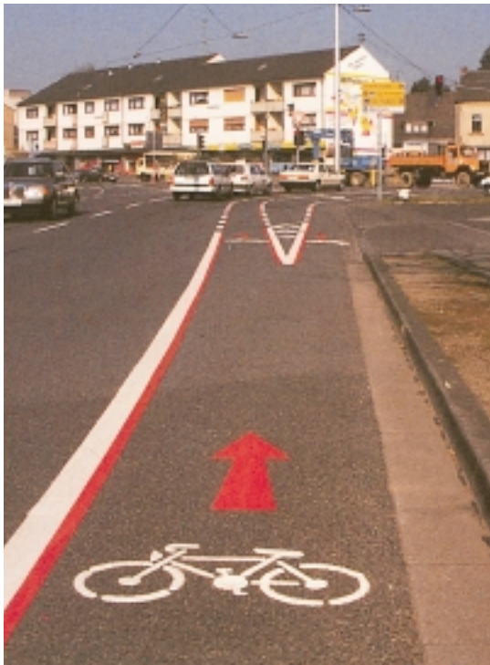
Der Troisdorfer "Rote Faden": Radverkehrsanlagen müssen deutlich als solche erkennbar und vor allem einheitlich gestaltet sein. Bei gebauten Radwegen sind beiderseits eingelassene rote Pflastersteine oder Platten, bei Markierungslösungen besteht der rote Faden aus einem 5 cm breiten roten Beistrich. Diese Rot-Weiss-Kombination hat eine deutliche Signalwirkung und weist sowohl Auto- als auch RadfahrerInnen auf die für den Radverkehr bestimmten Flächen hin.
