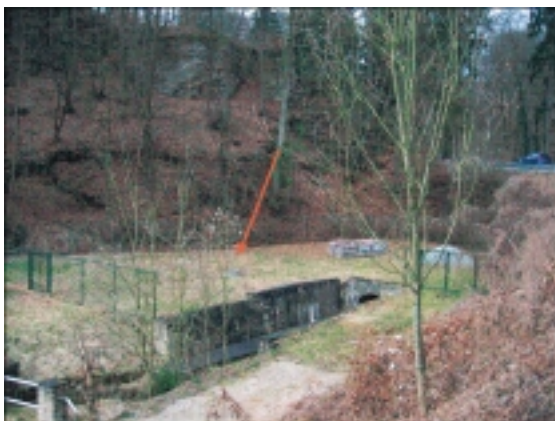
Quellfassung unterhalb einer Straße
