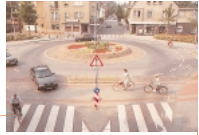
Der Kreisverkehr vorher und nachher: die Fahrbahn wurde im Zuge des Umbaus deutlich eingeeignet und umlaufend wurden Radspuren markiert. Im Vordergrund führt die Veloroute tangential über den Kreisverkehr, so dass Radfahrer direkt geradeaus weiterfahren können. Durch Aufpflasterungen wurde die Furt der Veloroute sicher gestaltet.
