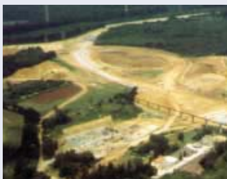
Wie lange soll in Luxemburg das jahrelangen Tauschen um die Umsetzung der Impaktstudienrichtlinie für Straßenbauprojekte noch weiter gehen? Es gilt endlich Nägel mit Köpfen zu machen!
