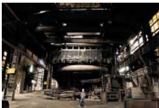
Ein Beispiel für ein Element der Anlage, das gemäß heutigen Plänen abgerissen werden soll, obwohl dies unverantwortlich wäre, die "Halle de Coulée Haut fourneau B". Hier müssten unbedingt das Volumen und die Struktur der Halle beibehalten, und über Umnutzungen nachgedacht werden (Foto Lex Kleren)
