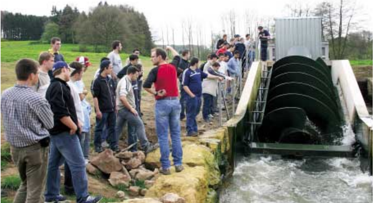
Sogar innovative fischfreundliche Kleinstwasserkraftwerke müssen zuerst massive administrative Hürden umschiffen bevor sie bezuschusst werden
