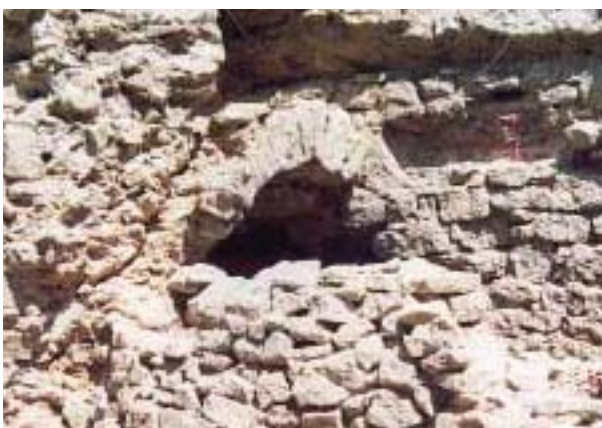
Hohlräume im Grottenbereich: ein "frisches" Uhu-Ei wurde dort im März 2004 entdeckt
