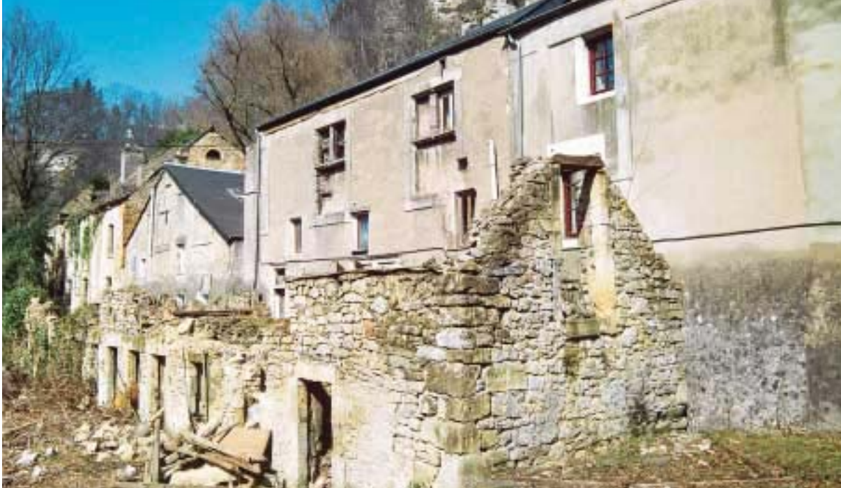
Ein verfallenes Badehaus (um 1820 errichtet) erstreckt sich parallel zur Palastfassade: die Kreuzstockfenster (teilweise verbaut) waren einst Teil der großen Galerie
