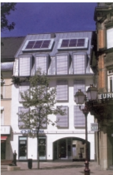
Das gleiche Niedrigenergiegebäude von außen.
